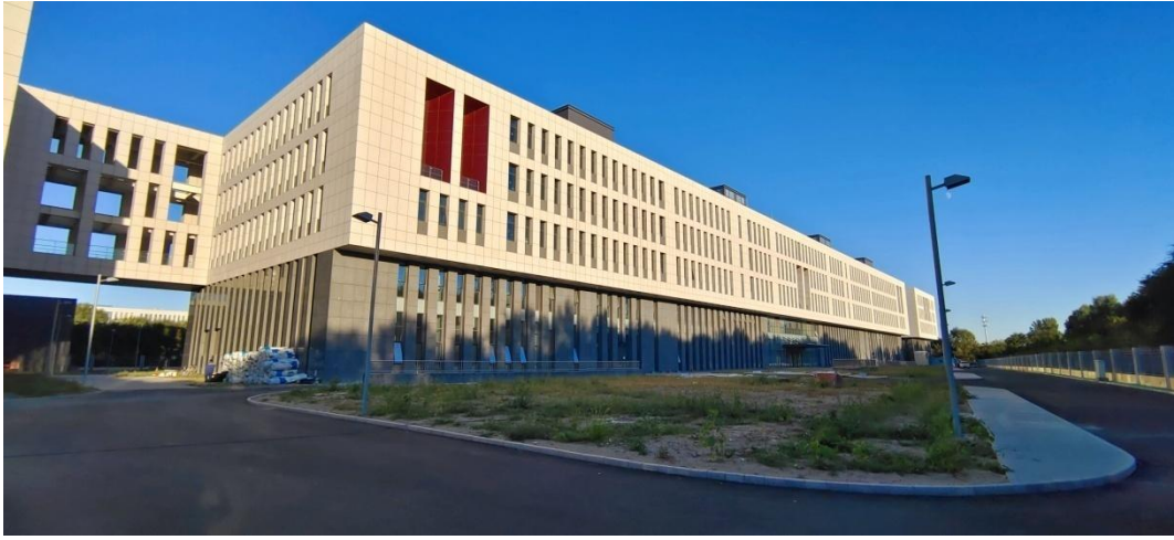
西区建筑主体与室外工程
