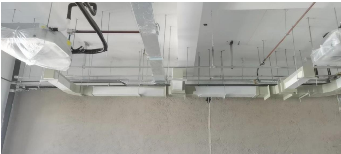
📍 前沿院改造项目施工进度
