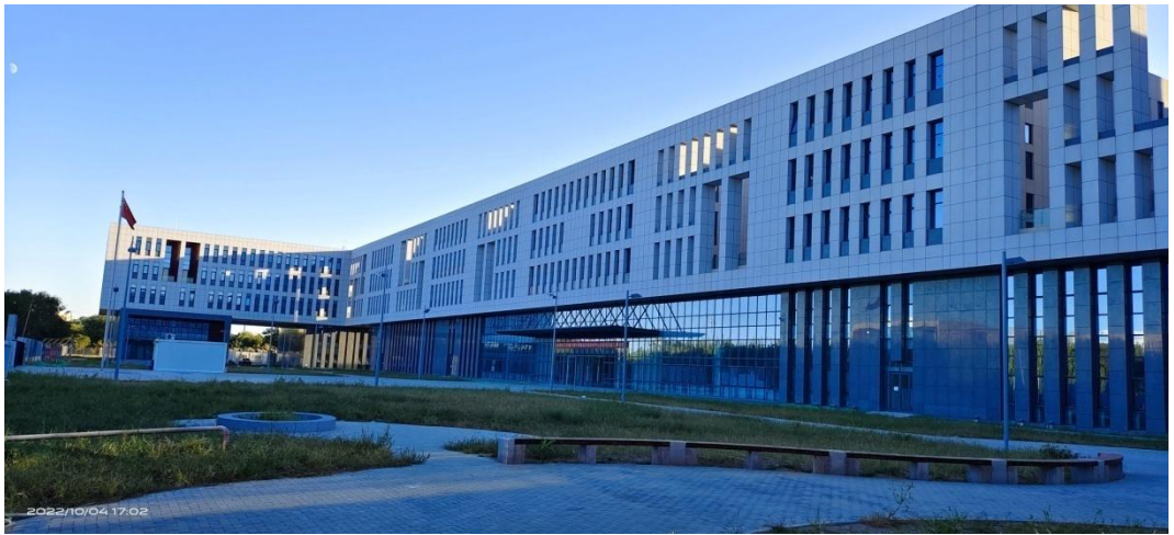
西区建筑主体与室外工程
