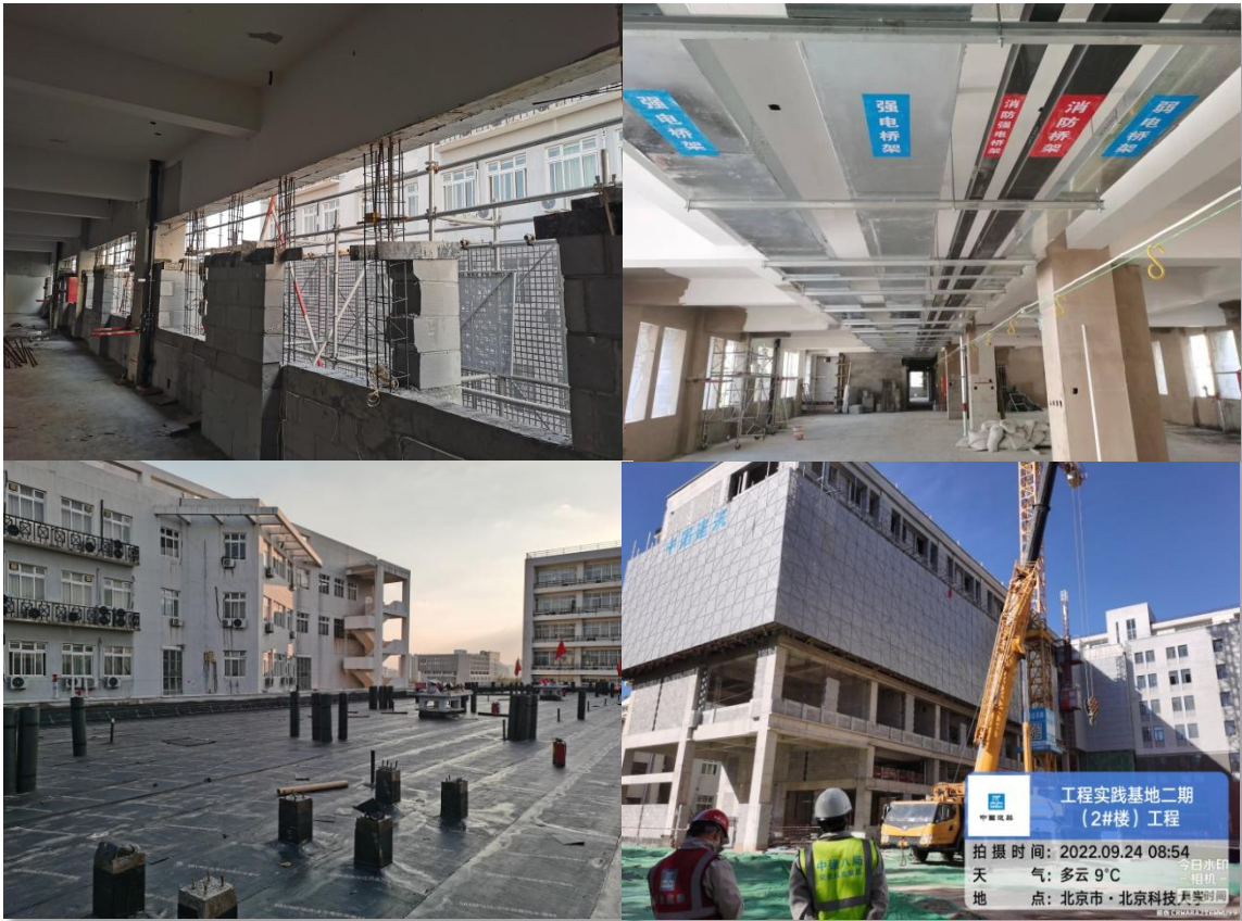
📍 工程实践基地（二期）施工进度
